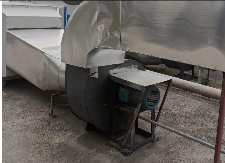
图 3-7 设备基础减震
