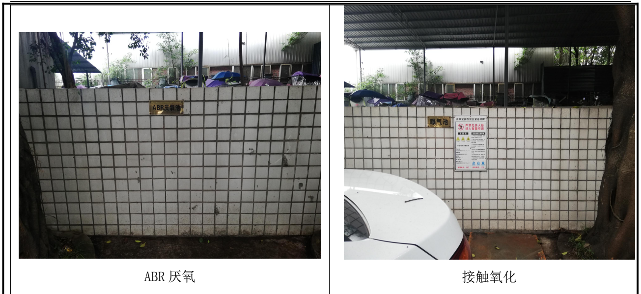
图 3.2 废水处理设施图
